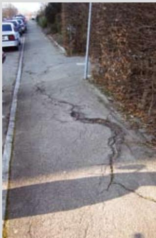
Ce revêtement, altéré par la poussée des racines, est un obstacle à la mobilité piétonne. Une intervention corrective s'impose.
