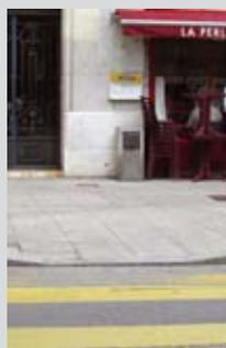
A la hauteur des traversées piétonnes et aux entrées carrossables, le dévers peut exceptionnellement atteindre 6% à cause de l'abaissement du trottoir. Lorsque cette limite est dépassée aux traversées piétonnes, la pose d'une main courante sur le bord intérieur du trottoir (côté opposé à la chaussée) peut rassurer certains piétons.
